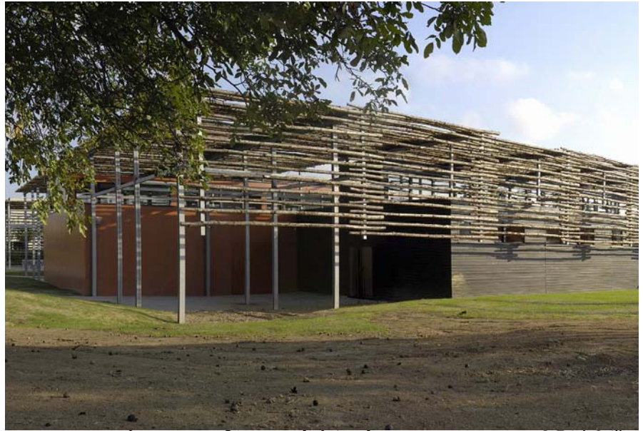
Restaurant administratif à Bron (Rhône)
